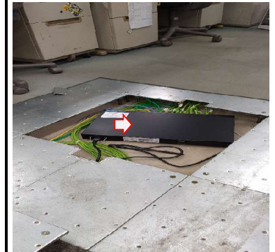
スイッチングHUB設置場所 (SR-S) <床下>
